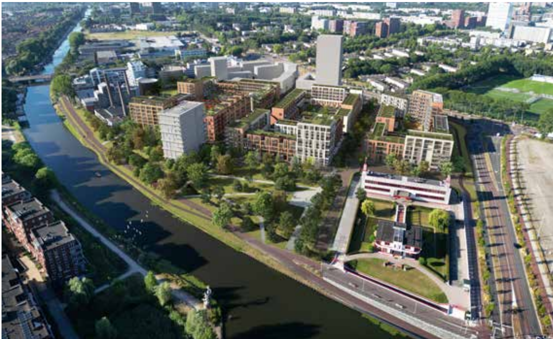
Nieuwe stadswijk De nieuwe Defensie, Merwedekanaalzone
