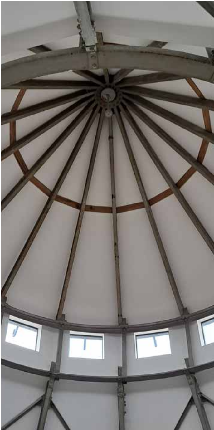
Dakconstructie koepel van de watertoren Amsterdamsestraatweg
