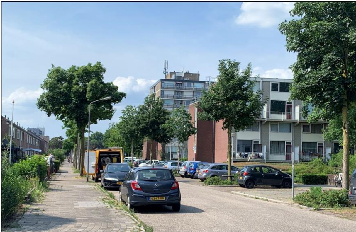
Strokenbouw van Woonwaarts langs de Balladestraat met op de achtergrond hoogbouw bij het wijkcentrum
