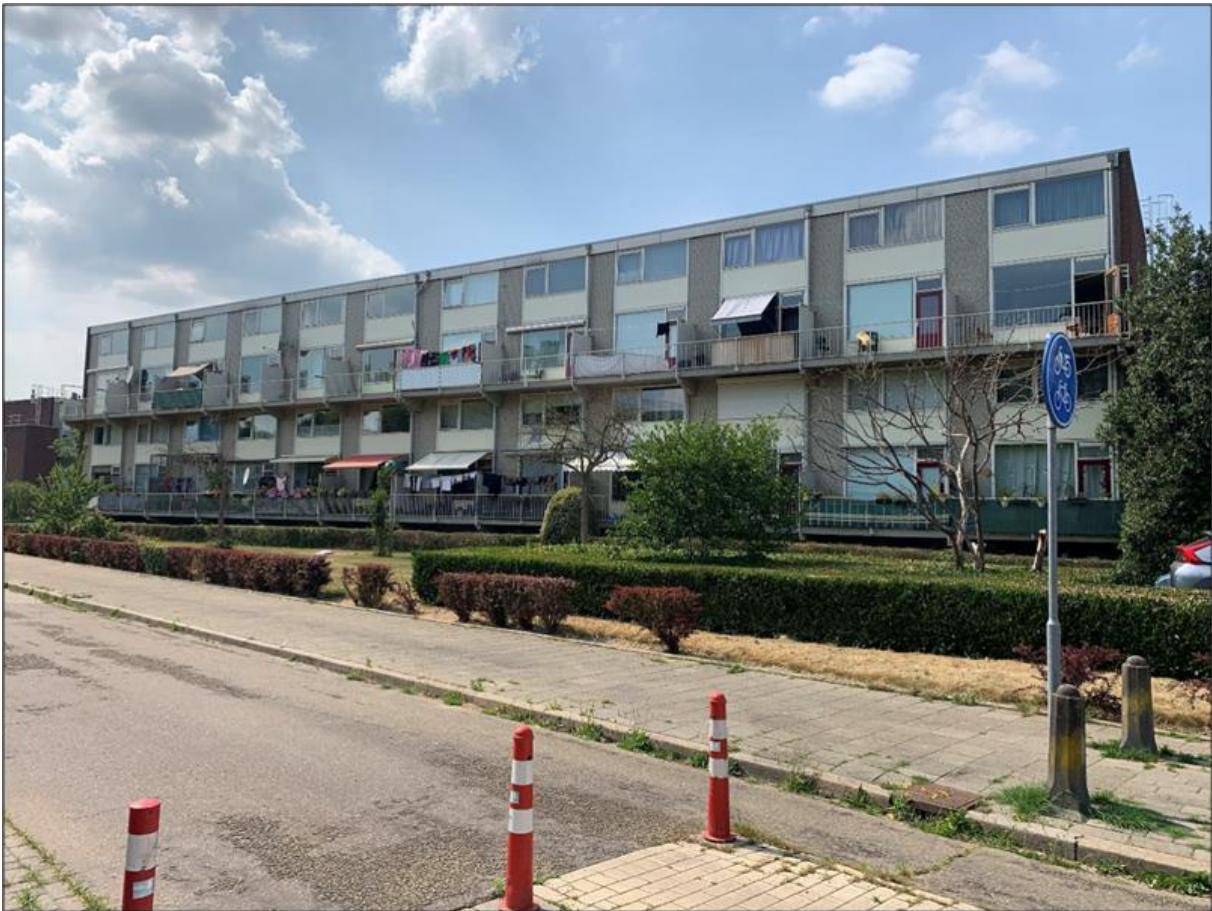
Woonwaarts-bouwblok langs de Serenadestraat
