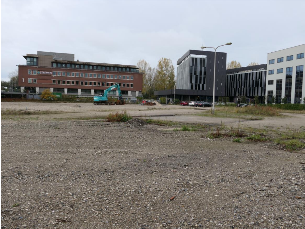
Figuur 3 Plangebied gezien vanaf het noorden.
