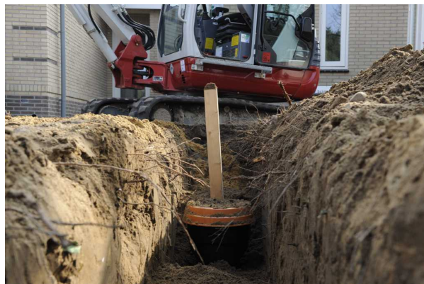
Figuur 12: Voorbeeld erfscheidingsput - Bron: GAW Stichting Rioned
