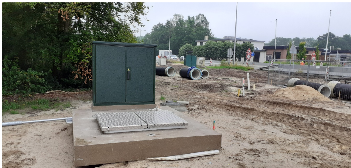
Figuur 10: Rioolgemaal Eperweg en aanleg nieuw riolering
