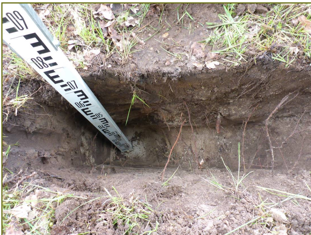
Afbeelding 15. Profielkuil 4 bij boom 4
