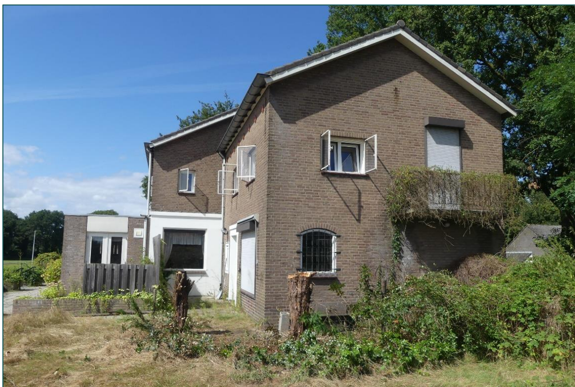
Figuur 2 Het pand van het voormalige restaurant is opgebouwd uit gemetselde muren met een luchtspouw en heeft een zadeldak met dakpannen.
