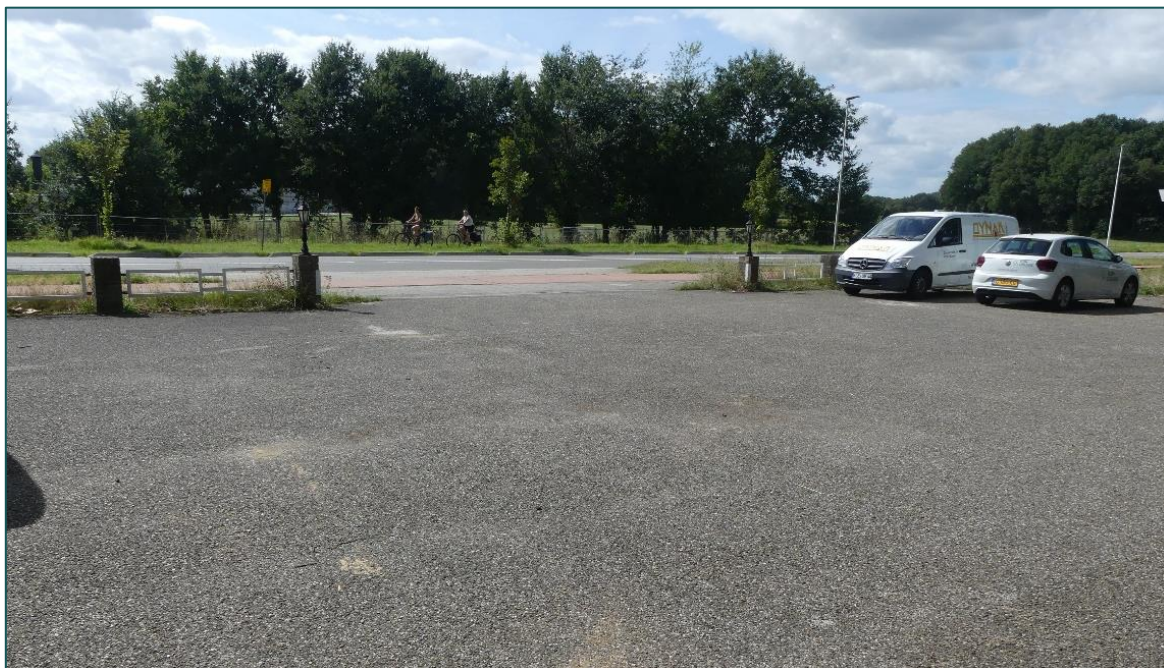
Figuur 4 De parkeerplaats bij het voormalige restaurant is volledig geasfalteerd.
