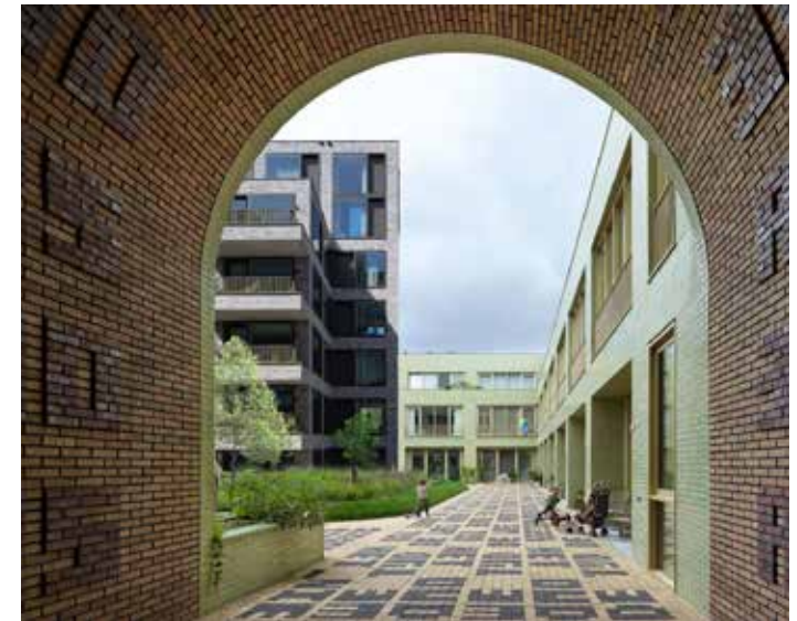
▲ De onderdoorgangen naar de binnenhof zijn 6 meter breed en 6 meter hoog.
