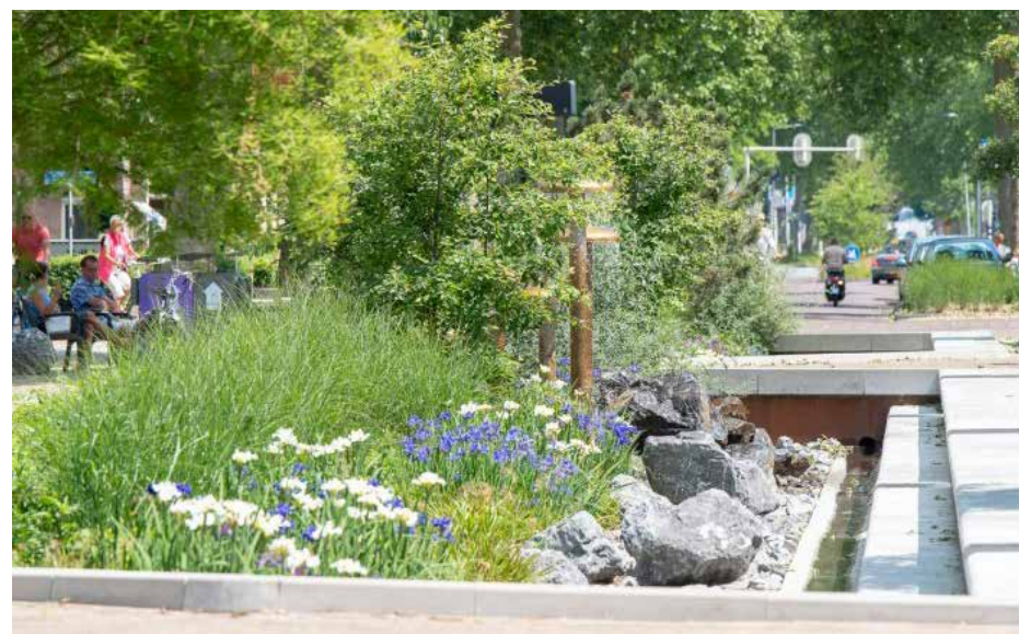
▲ Een regentuin houdt water vast en voert overtollig water af.
