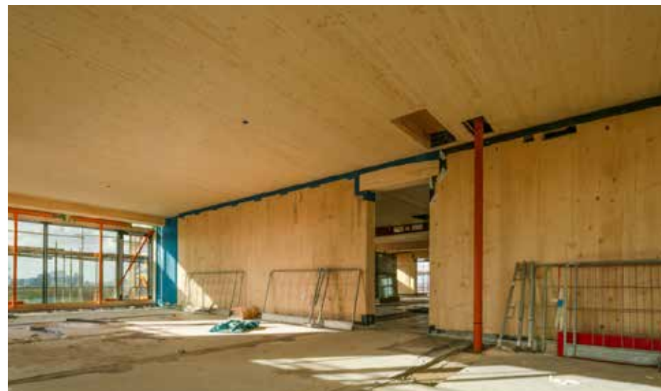
▲ Bouwen in hout: duurzaam en circulair.
