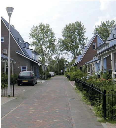
Trottoir en rijbaan op één niveau
