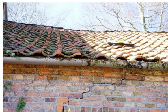
Close-up van de dakrand.
