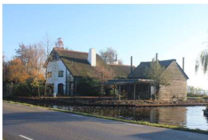
De te slopen woning met schuur. Watergang langs Noordenseweg.
