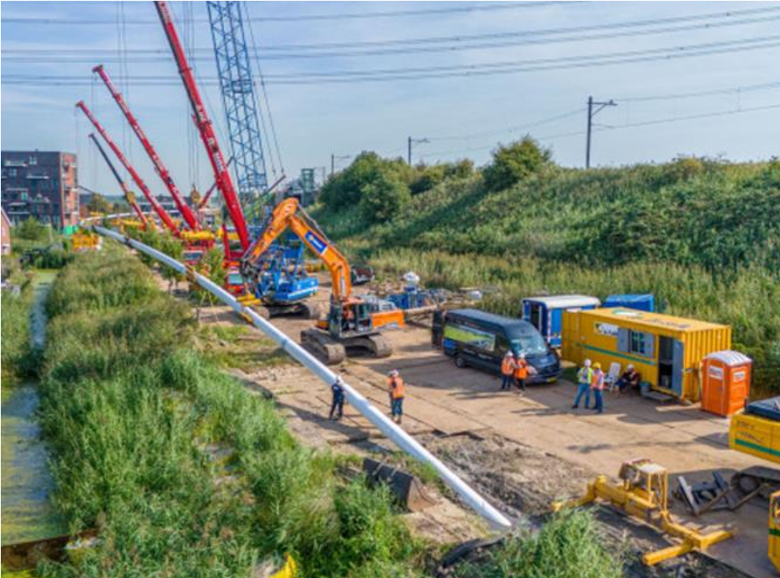
Boring onder de Merwede
