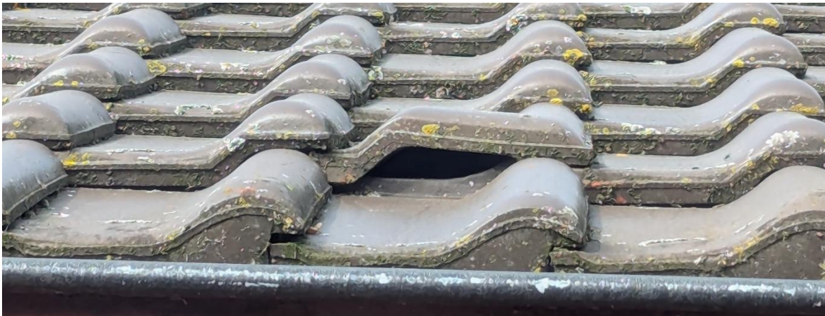
Afbeelding 4: Geschikte invliegopening in het pannendak.
