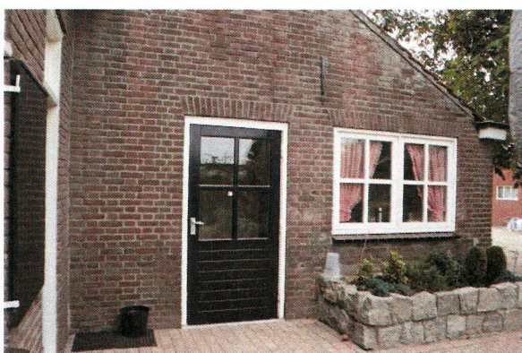
Oorspronkelijke uitbouw tegen achtergevel
