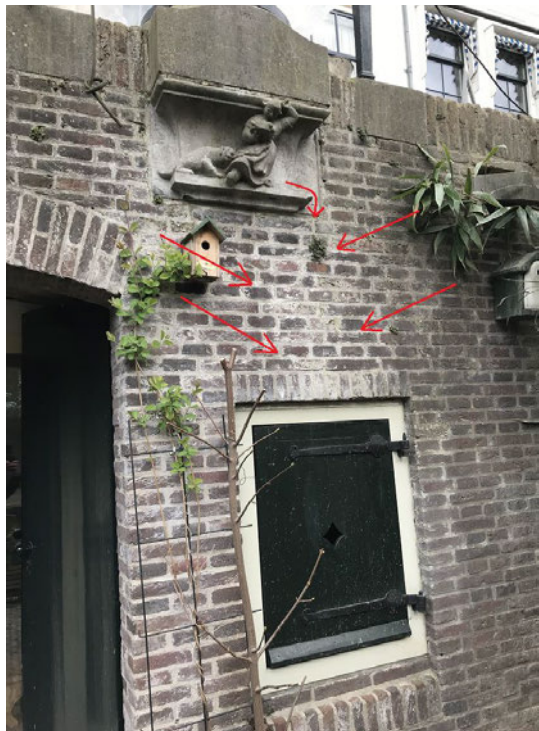
Afbeelding 4.8 Concentratie van water onder lantaarnpaal boven raam nummer [REDACTED]
