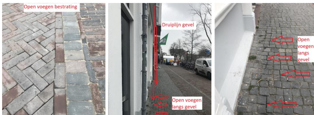
Afbeelding 3.9 Open voegen straatwerk (linker afbeelding) en druiplijn gevel (rechter afbeelding)
