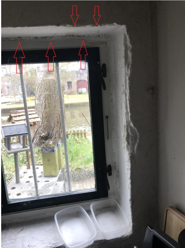
Afbeelding 2.4 Lekkage in raam nummer [REDACTED]
