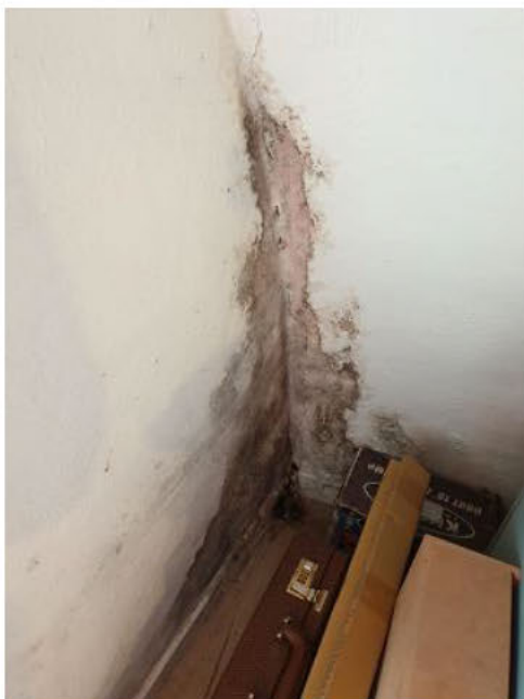
Afbeelding 4.6 Voorbeeld (nummer [REDACTED]) van driehoekige vorm van doorslag aan voorzijde van kelder
