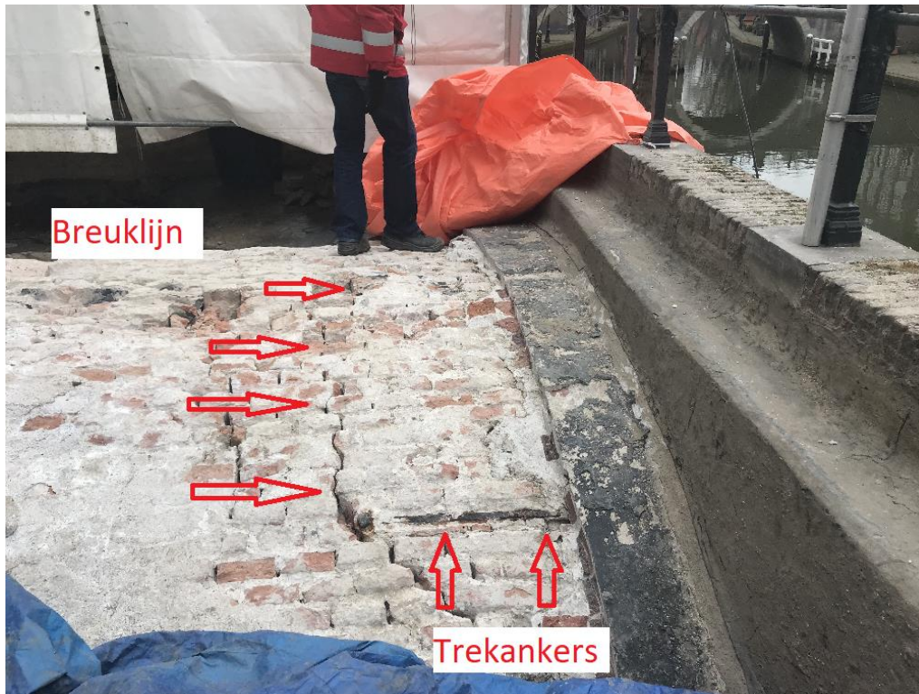
Afbeelding 4.9 Breuklijn in kelderboog nummer [REDACTED] als gevolg van zetting
