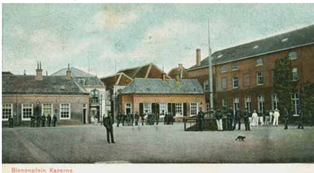
Afbeelding 6. Binnenplein van de Kazerne, het voormalige kloostergebouw van de Graue Zusters. 1814-1992.
