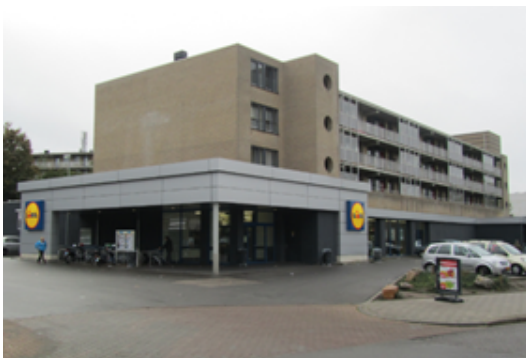
Supermarkt met woningen aan de Anjelierstraat
