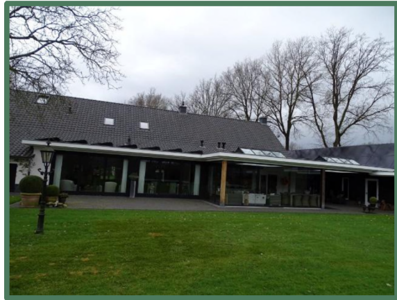
Foto 4: Noordoostzijde woning met kantoor, aanbouw.
