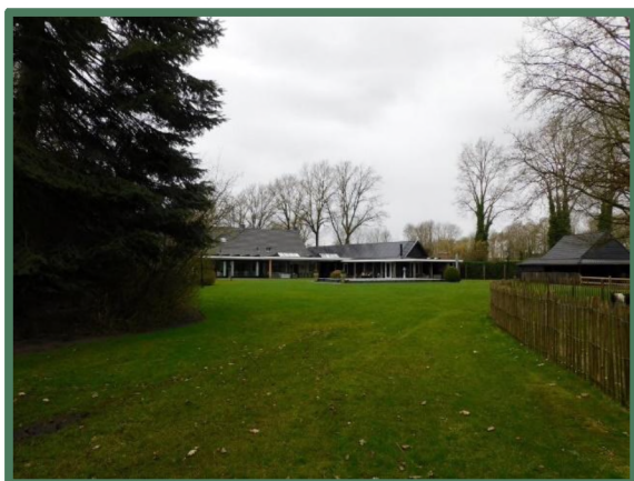
Foto 11: Overzicht tuin noordoostzijde en tevens bouwlocatie voor de nieuwe woning.
