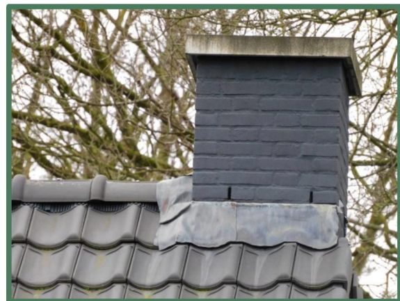
Foto 18 & 19: Open stootvoegen in schoorstenen van woning met kantoor.
