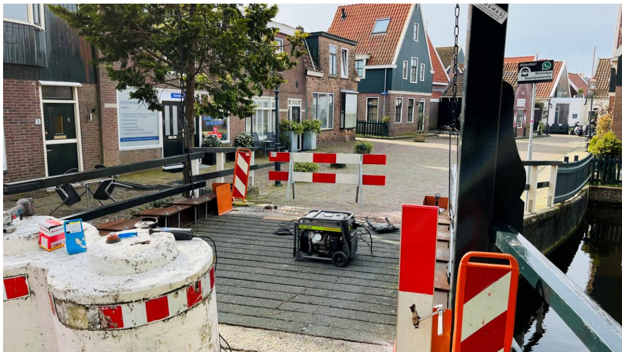
Foto – afsluiting, bouw noodconstructie
