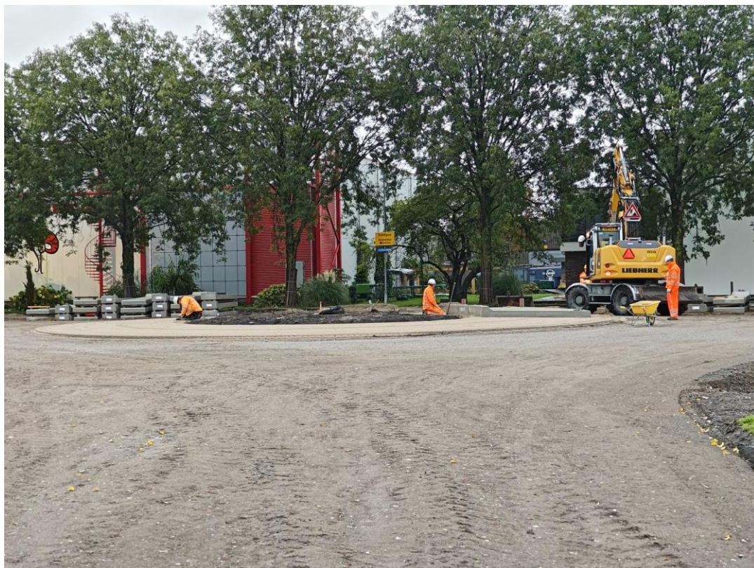
De aanleg van de nieuwe rotonde bij de Dijkgraaf de Ruiterlaan in de 6 e fase van de Corridor
