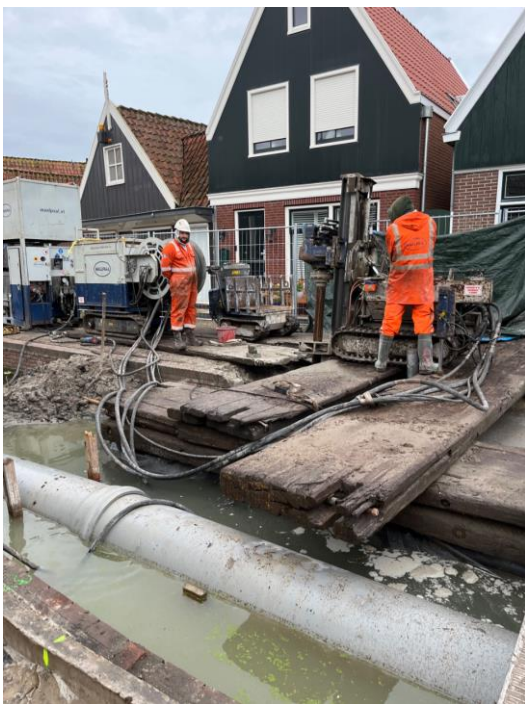
Foto – aanbrengen boorpalen brug V06
