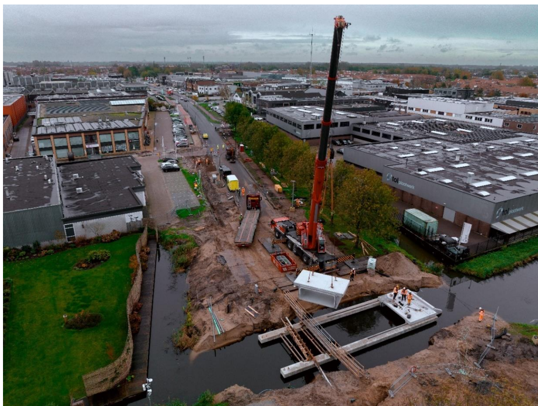
Het hijsen van elementen van de nieuwe duiker bij het Noordeinde
