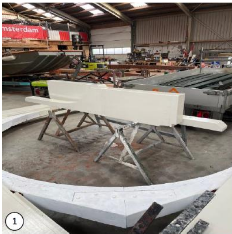
Foto – Hameipoort houtrot herstellen en schilderwerkzaamheden
