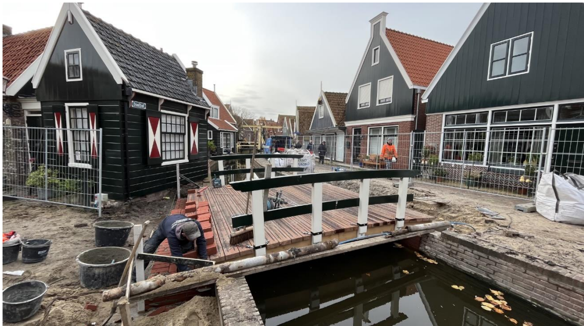
Foto – werk aan de nieuwe brug
