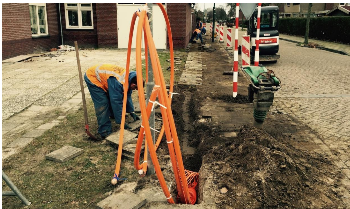
Start glasvezelaanleg GEV
