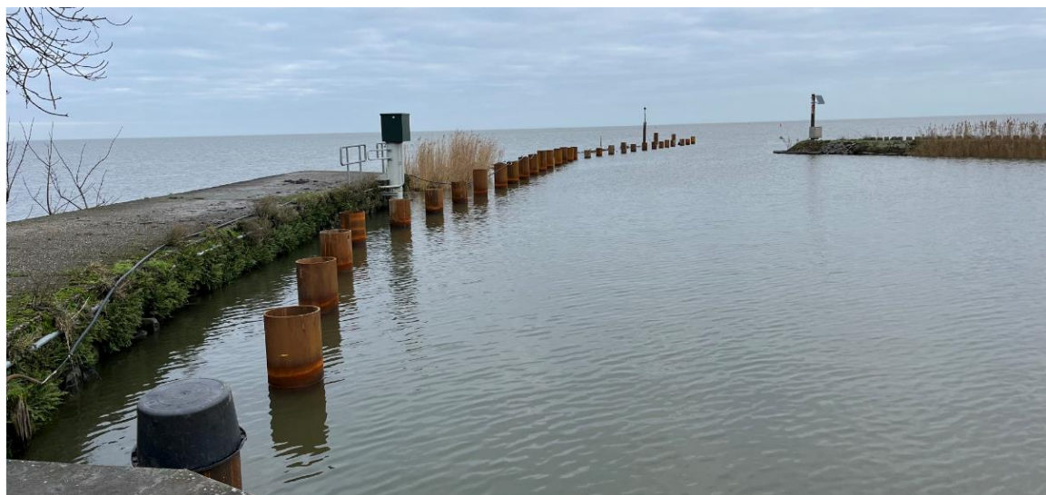
Foto – stalen buispalen voor de nieuwe Pier
