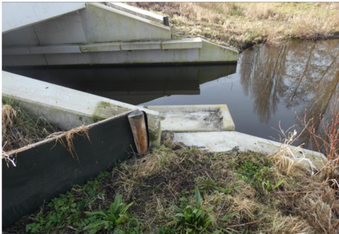
Afbeelding 3.2 Duiker voorzien van looprichels
