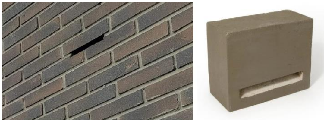
Figuur 6.2 Voorbeeld horizontale (open) lintvoeg (links) en entreesteen (rechts) toegankelijk voor vleermuizen. Bron foto's: Ecogroen & Traasnaturecare.com
