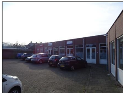
Figuur 7. Oostzijde van de onderzoekslocatie.
