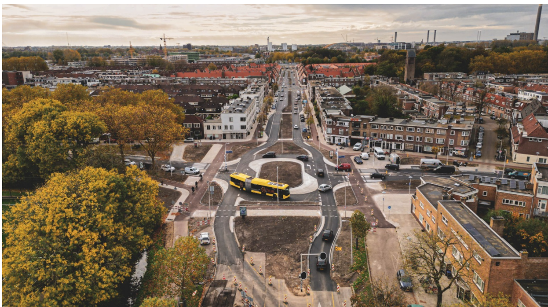
Afbeelding: Westelijke Stadsboulevard in aanbouw
