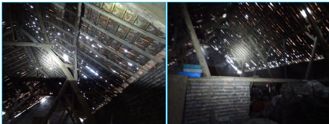
Foto's: Indrukken plangebied. Binnenzijde schuur.
