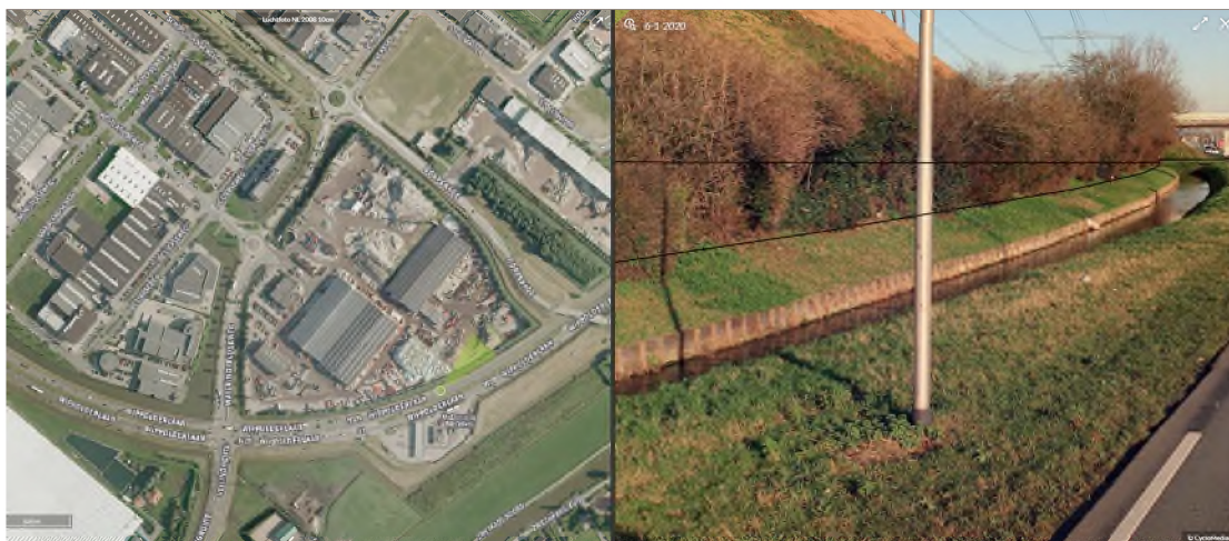
Figuur 5-17: Huidige situatie watergang (bron: LuchtfotoNL 2019 © CycloMedia Technology B.V.)
