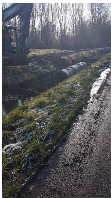
Figuur 6-6 Plaatsen duiker en damwanden.
