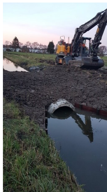
Figuur 6-7 Duiker afgedichten met aarde en dammen verwijderen.
