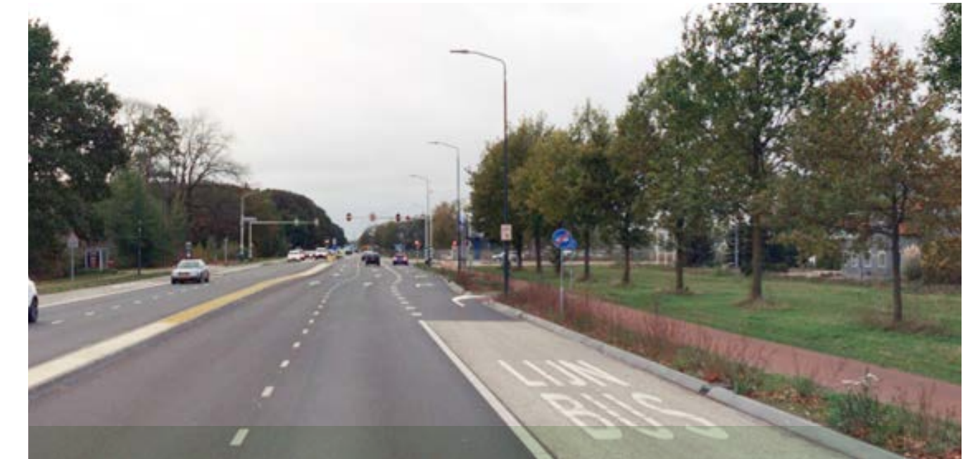
Aansluiting Eindhovenseweg/Hooge Akker na herinrichting, met dubbele opstelstrook voor rechtdoorgaand verkeer.
