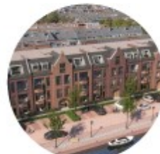
Appartementen aan het water
