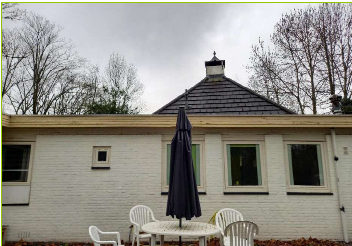
Het te saneren gebouw heeft deels een leiplaten dak en is aan meerdere kanten omgeven door hoge bomen
