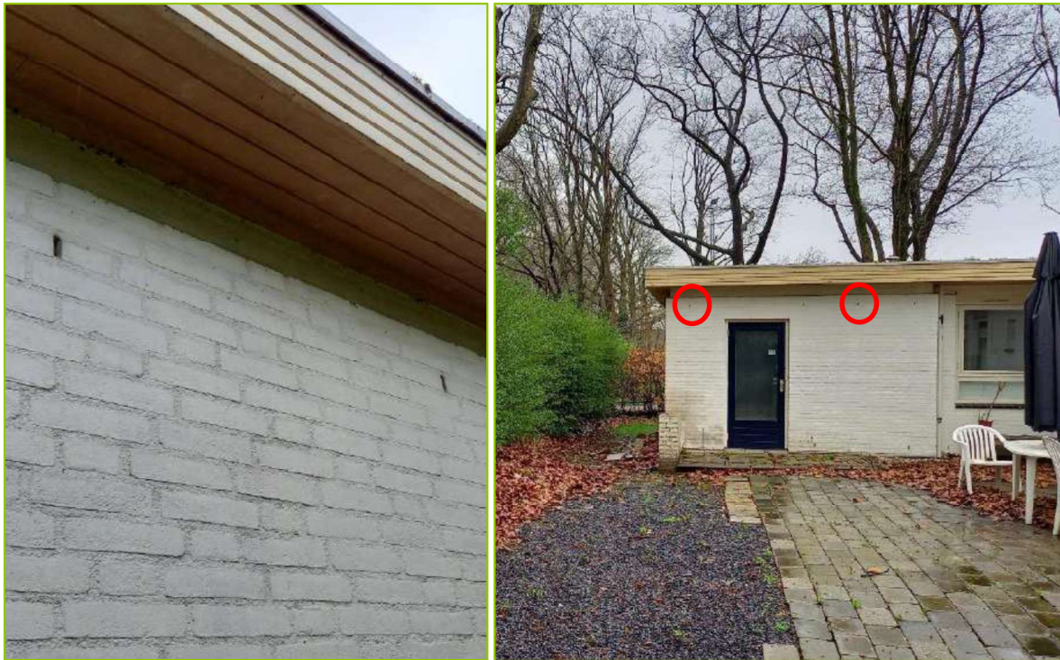
Figuur 2 Detail van de open stootvoegen met een overzichtsfoto
