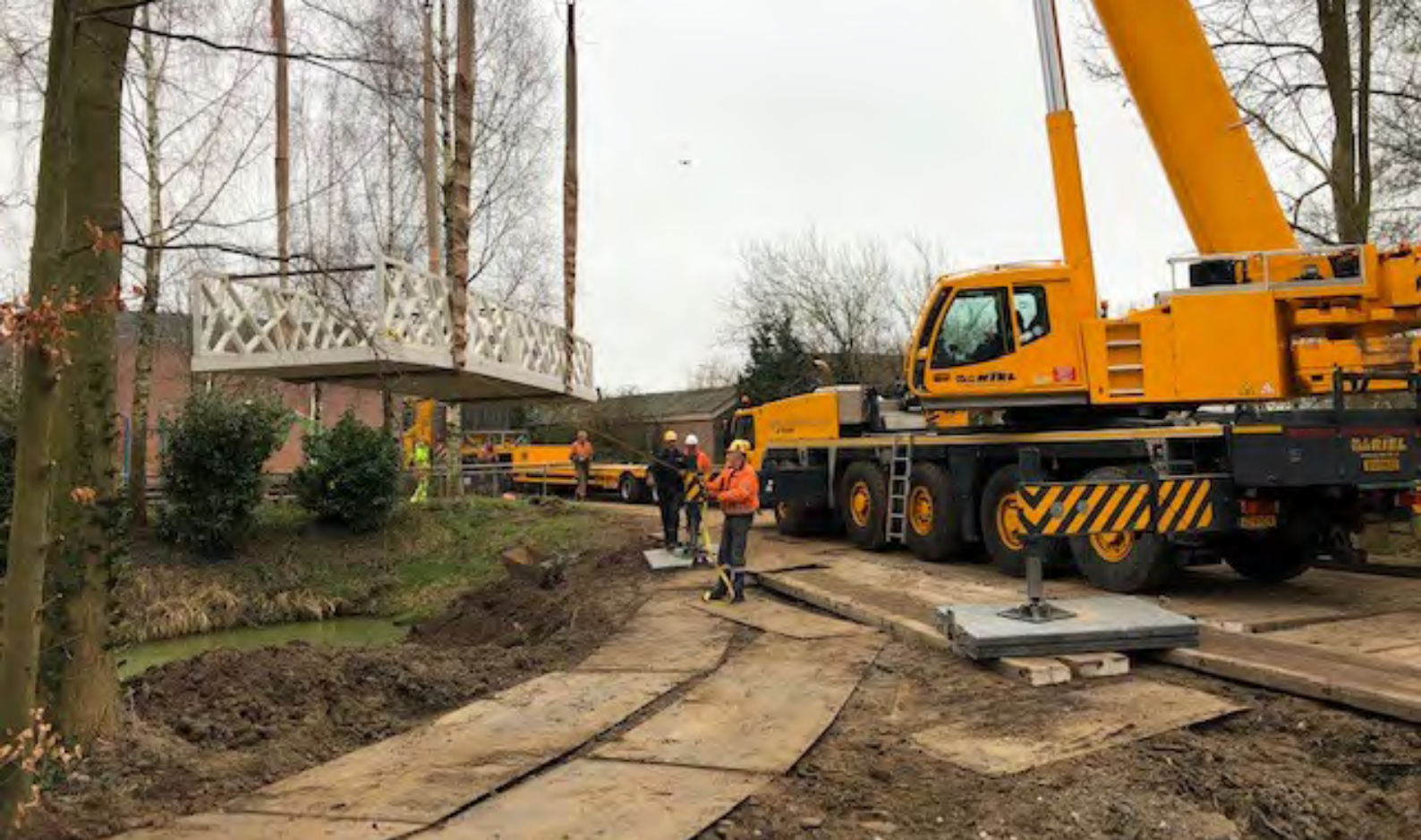
Het vervangen van een duiker door een brug in Lunetten
