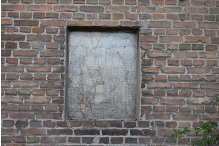
Later gerealiseerde en dichtgezette opening.
