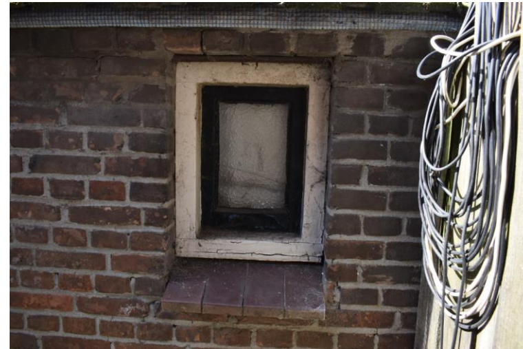
Achterevel bedrijfsdeel met houten vensters.
