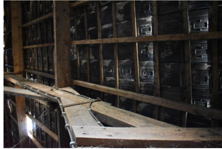
Houten constructie met moerboutverbinding.
