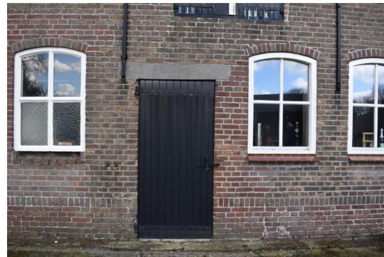
Staldeur onder betonlatei met rechts de vernieuwde stalvensters.
