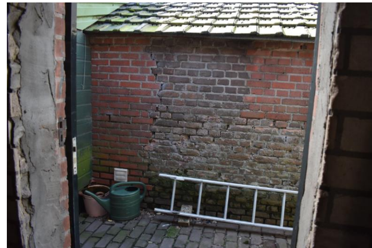
Achtergevel bedrijfsdeel linkzijdig dichtgezet venster en inboetwerk.
