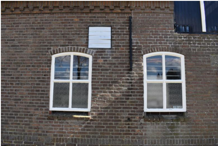
Twee betonnen vierruits vensters.
