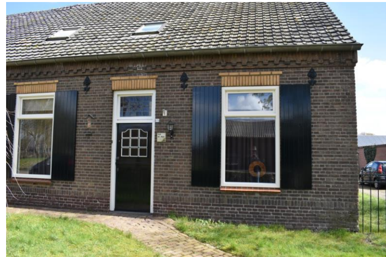
Rechterzijde vorgevel woondeel.
