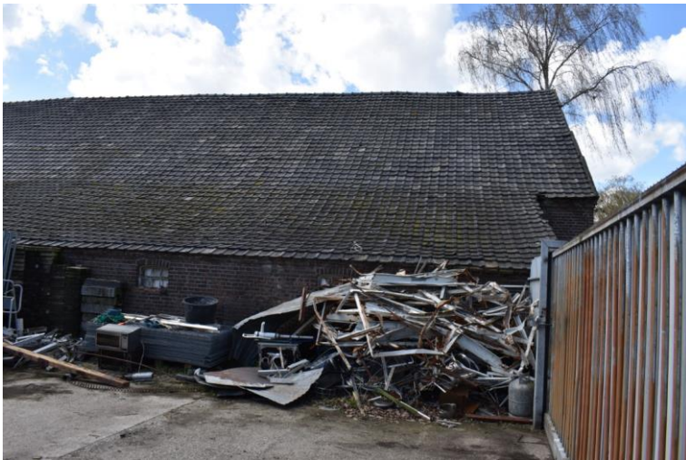
Achterevel bedrijfsdeel met houten vensters.
