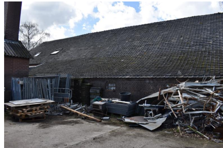
Het woondeel uiterst links en het bedrijfsdeel rechts.
