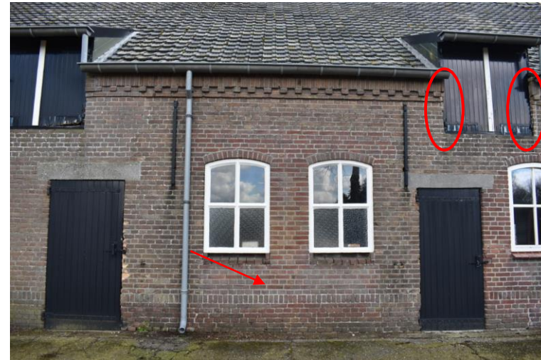
Staldeuren onder betonlatei met twee betonnen vierruits vensters en twee later geplaatste hooiluiken. De rode pijl wijst het inboetwerk aan. Rood omcirkeld de bouwsporen rondom het hooiluik.
