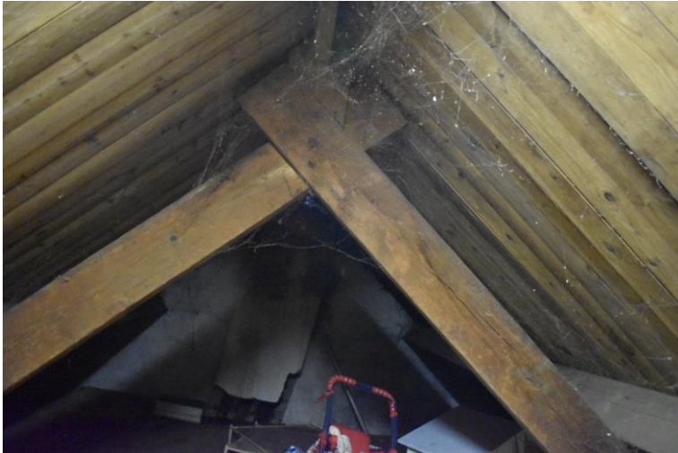
Houten constructie met boutverbinding woondeel.
