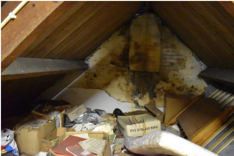
Restant van de oorspronkelijke schoorsteen.
