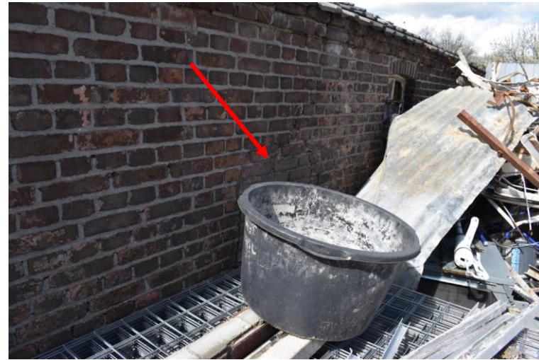
De rode pijl wijst een dichtgemetselde varkensdeur aan.
