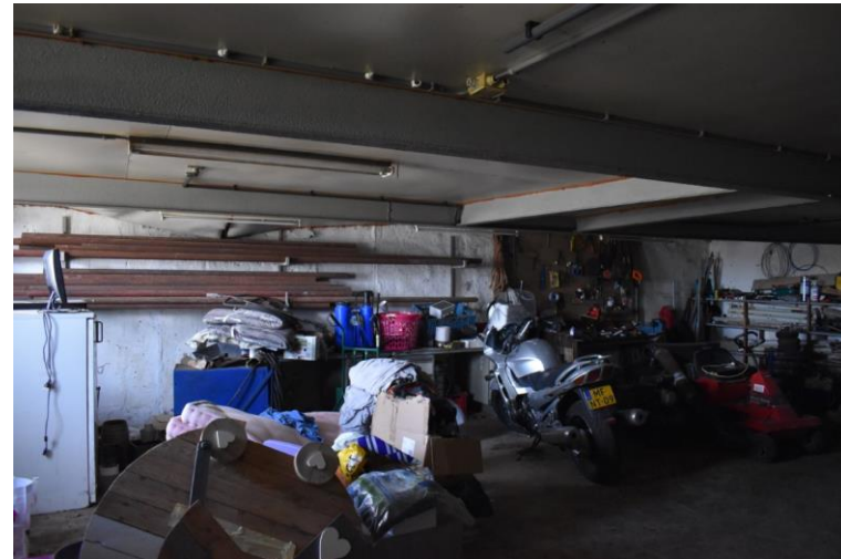
Bedrijfsdeel met stalen vloerconstructie.
