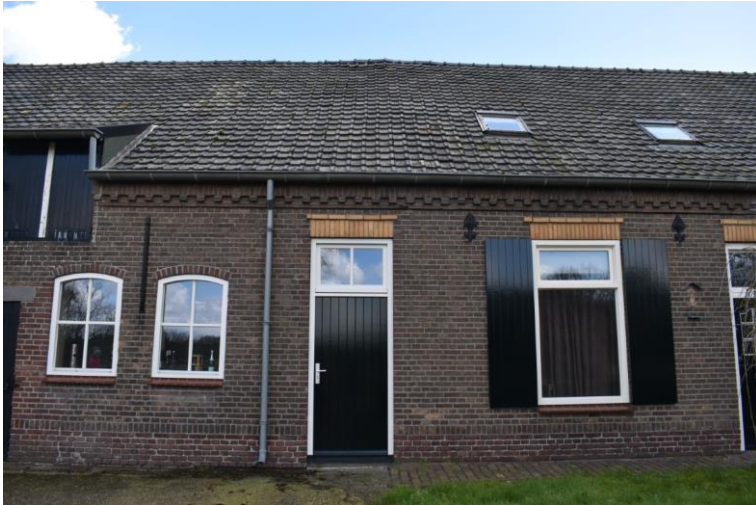
Links het bedrijfsdeel rechts het woondeel.
