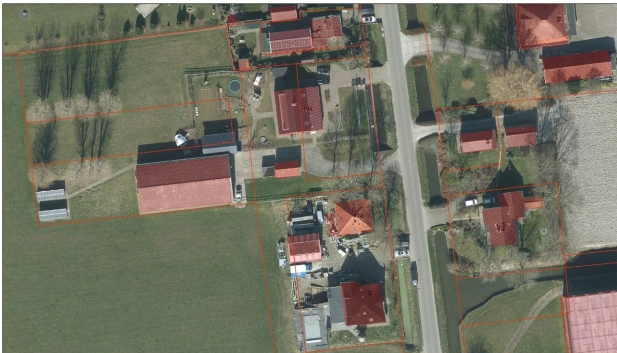
Figuur 1. Actuele gemeentelijke luchtfoto met bebouwingssituatie aan de Veenhuizerweg 47 en 49a.
