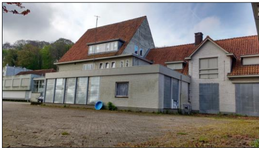
Het te slopen ontvangstgebouw.
