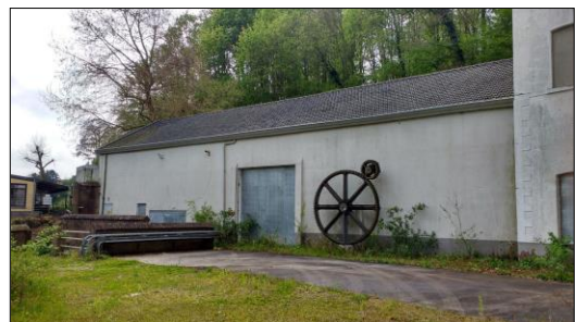
Zicht op een deel van de monumentale bebouwing van de voormalige brouwerij.
