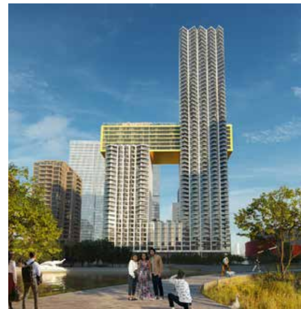
Het brugvolume kan als een zelfstandig volume herkenbaar zijn Sax, Rotterdam, MVRDV
