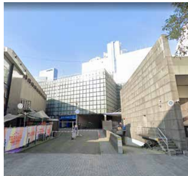
Expositiehof parkeergarage Kruiskade 21
