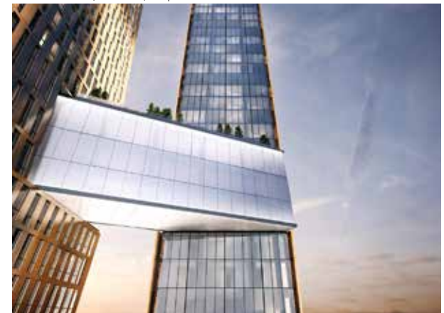
Twee torens met elk een eigen uitstraling verbonden door een luchtbrug
