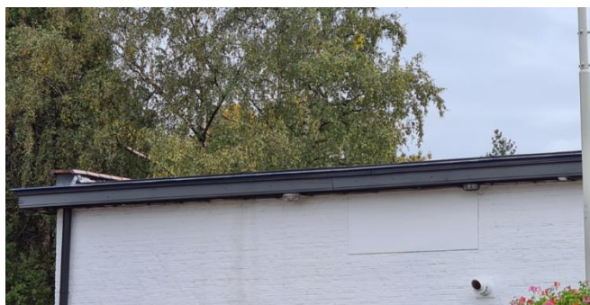
Figuur 7: Dakrand van het bedrijfspannd
