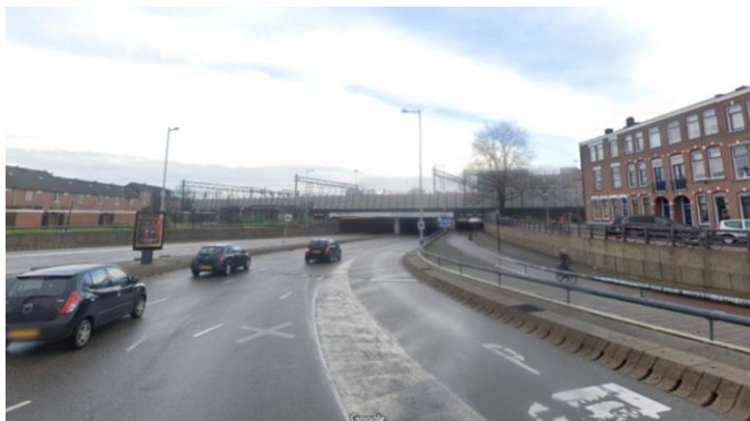
Daalsetunnel Lombokzijde. Veel rijbanen, harde verkeersomgeving, woonbuurten op afstand.
