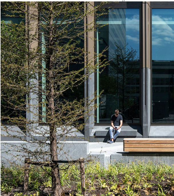
Geveldelen zonder entree bieden wel zicht naar binnen en hebben een zorgvuldige aanlanding
