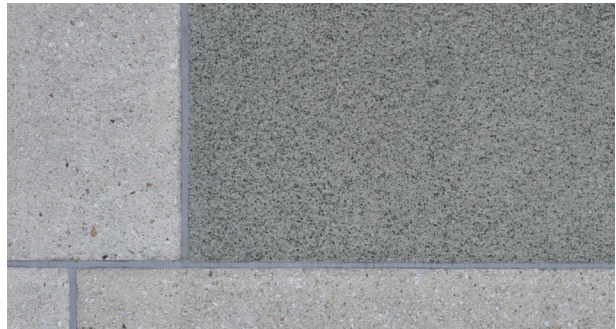
schokbeton met natuursteentoeslag
