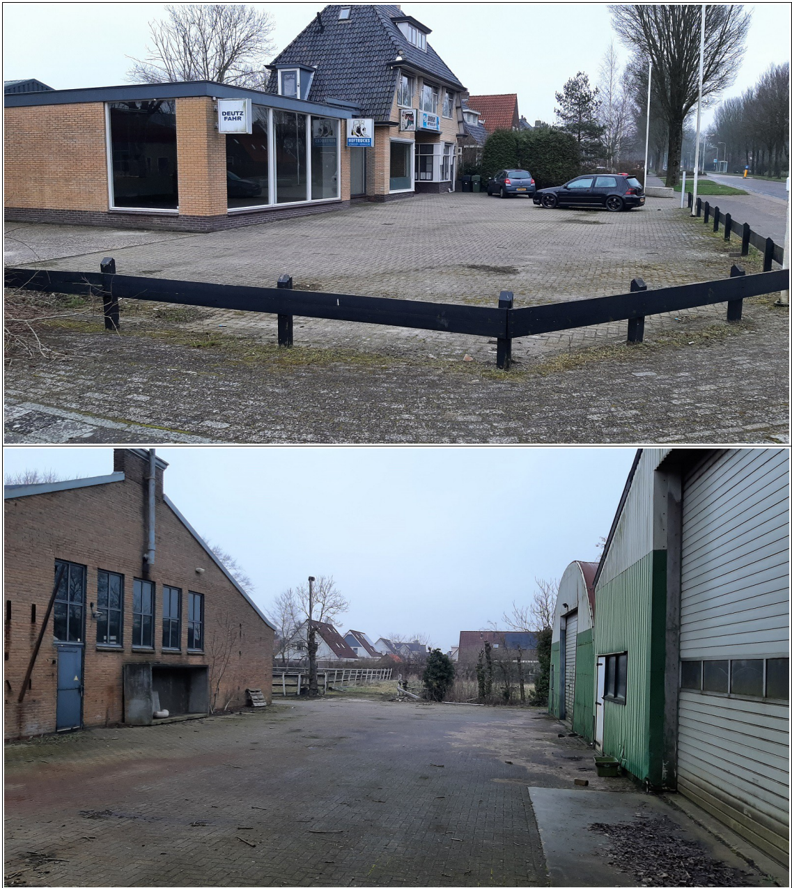
Figuur 4: Berlikum Bitgumerdyk 21: foto boven van de hoek tussen de Bitgumerdyk en de Bildtdyk, foto onder genomen tussen de loods aan de Bildtdyk (links) en de achter gelegen loodsen (rechts).
