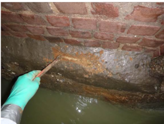
E: De mortel op de banketten is gemakkelijk weg te schrapen
