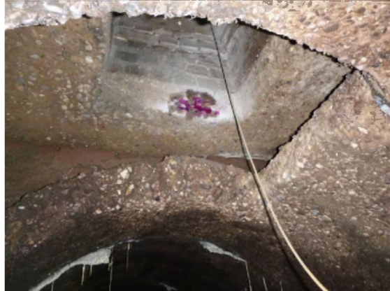
B: Blik vanuit het hooftriol op de putopening met dekplaat. Constructie goed te zien
