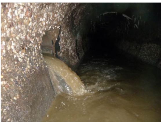
E: Inkomend AC persriool, ongeveer 2,5 meter stroomafwaarts vanuit de put
