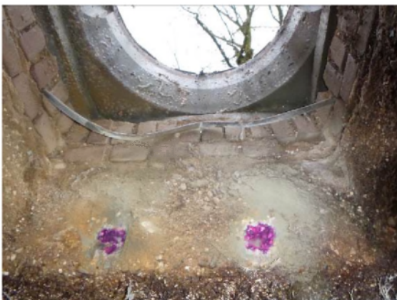
E: Kabel door de schacht van de put. Proeflocaties carbonatatie-test op de dekplaat
