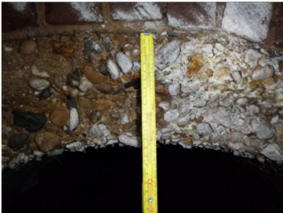
C: Gemeten grootste wanddikte van het hoofdriool 14 cm
