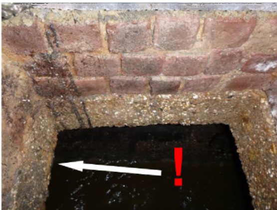
C: Vrij liggende gecorrodeerde wapening zichtbaar in de dekplaat
