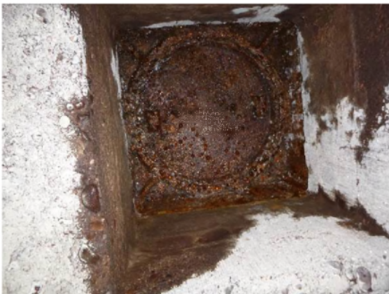
C: Deze putdeksel ligt onder het maaiveld, ongeveer 4 meter stroomopwaarts vanaf put 508G003
