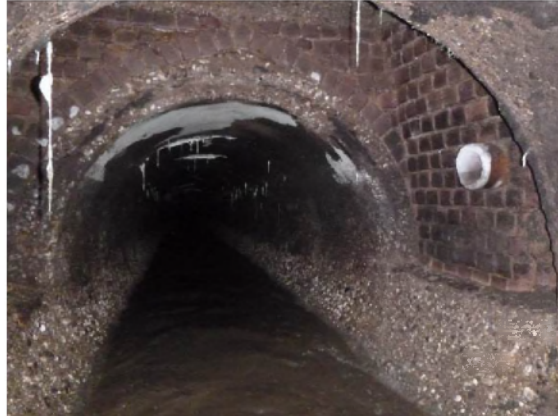
B: Blik vanuit het hoofdriool in de put. Rechts bovenin restanten van een zwarte coating zichtbaar
