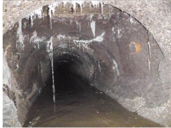
B: Blik vanuit het hoofdriool in de put met wortelingroei. Inkomende leidingen op putwand 2 en 4 geheel dichtgegroeid
