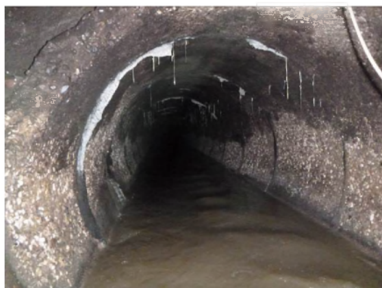
F: Blik in het sterk aangetaste afvoerende hooftriol
