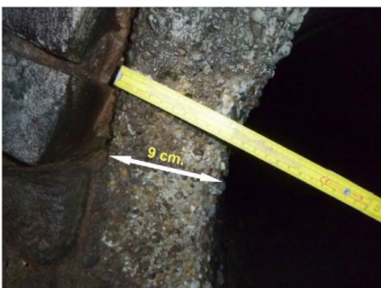
E: Detail van de wanddikte van het hoofdriool
