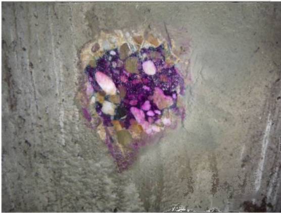
A: Carbonatatietest op putwand 2
