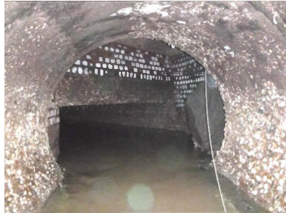
B: Blik vanuit het hoofdriool in de put met op de achtergrond een overkluizing stroomafwaarts met een betonnen dekplaat
