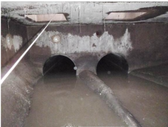
C: Overzicht van de put met het inkomend hoofdriool, verdeeld over twee buizen
