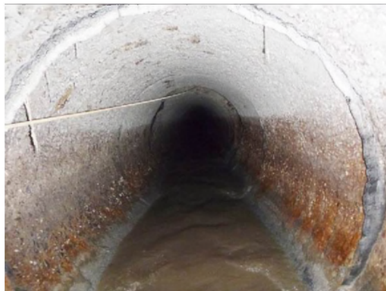
D: Overzicht van het hoofdriool, gezien vanuit de put, richting put 509G003
