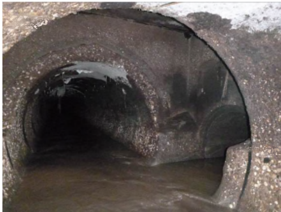
B: Blik vanuit hoofdriool in de betonnen put
