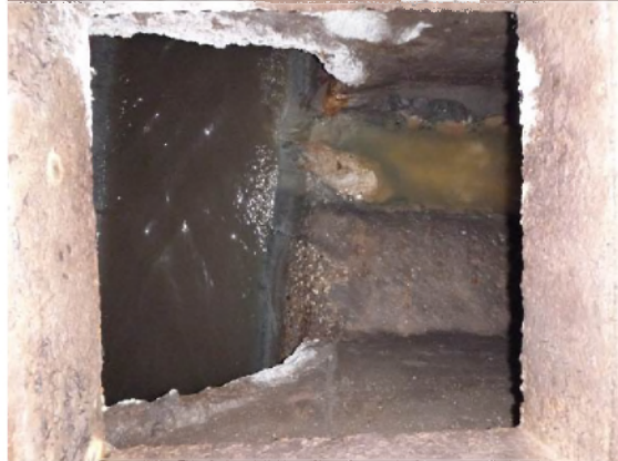
B: Blik in de put door de toegangsschacht met links het hoofdpijool en rechts een inkomende riool
