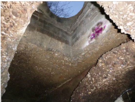
C: Vanaf putwand 2 gefotografeerd. Links de overkluizing voor een inkomend riool
