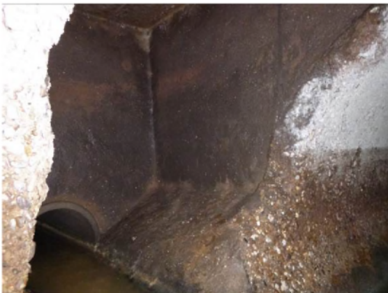
C: Blik vanuit het hoofdpijool in de put met rechts het aanvoerend hoofdpijool en links het inkomende riool. Het metselwerk is beraapt
