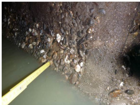
F: Sterk aangetaste delen van het hoofdriool met uitvallende kiezels
