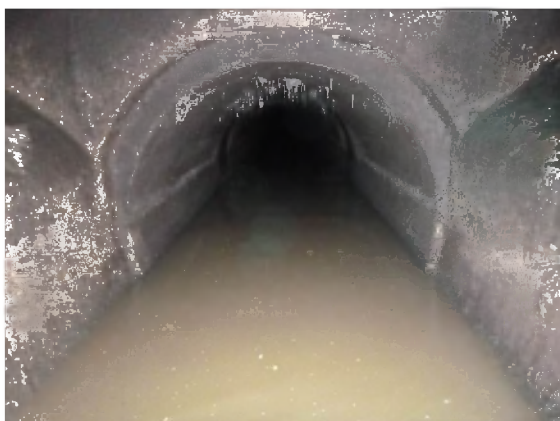
C: Blik in het inkomend riool op putwand 2
