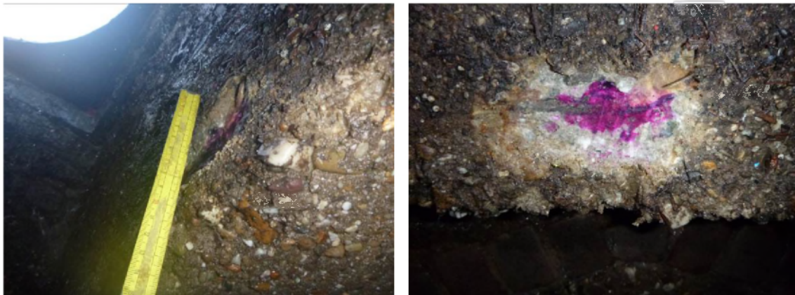
A: Carbonatatietest op de betonnen dekplaat B: Detail van de carbonatatietest
