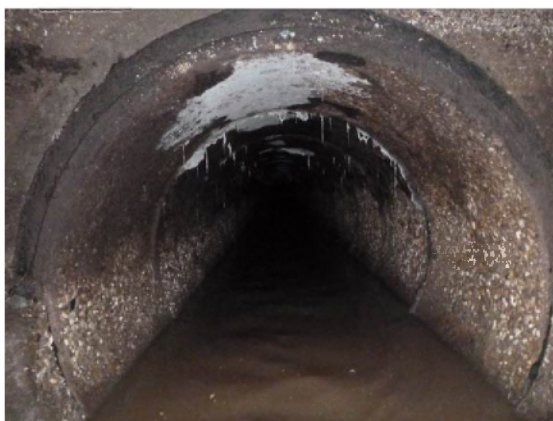
D: Blik in het aanvoerend hoofdriool op putwand 3
