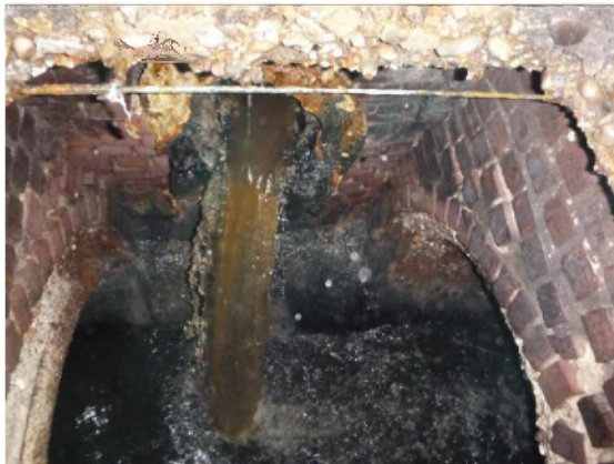
B: Blick van bovenaf in de put met zichtbaar de inkomende persleiding op putwand 4 en de vrij liggende wapening in de dekplaat
