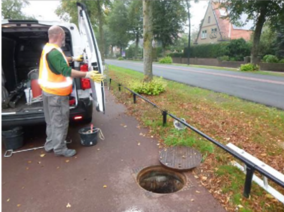
A: Stellagen metselwerk vanaf de betonnen dekplaat tot het maaiveld
