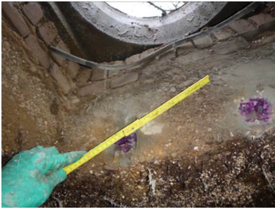
A: Carbonatatietest op de betonnen dekplaat
