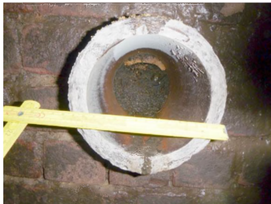
D: Met wortels dichtgegroeide inkomende leiding op putwand 4
