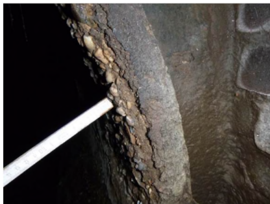
F: Wanddikteverlies door biogene zwavelzuuraantasting van het hoofdriool
