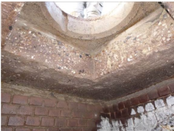
C: Blik vanuit de put op de betonnen dekplaat en putopening. Dekplaat en putafdekking lijken ooit vernieuwd te zijn
