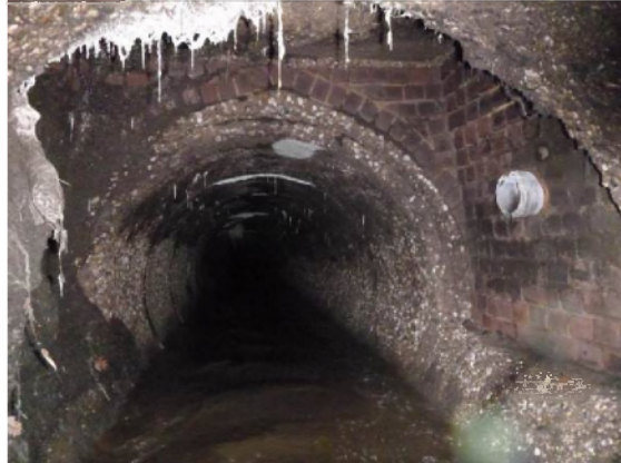
B: Blik vanuit het hoofdriool in de put met zichtbaar wortelingroei
