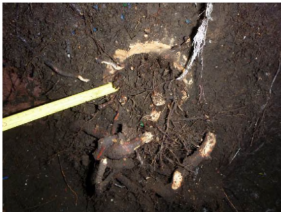
C: Detail dichtgegroeide leiding putwand 4
