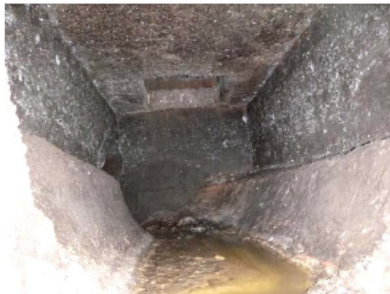
D: De overkluizing met het inkomende riool
