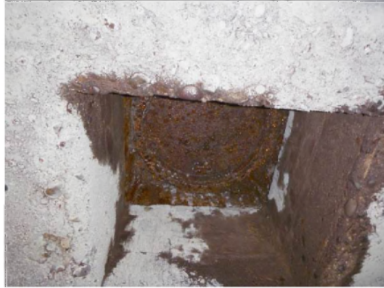
B: De betonnen dekplaat van de put en zicht op de verdekt liggende putdeksel
