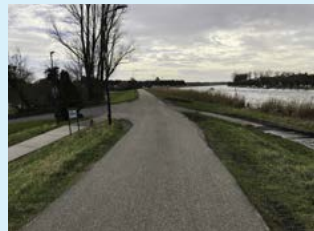
Foto's van restanten van de overhaal aan de Westdijk.
