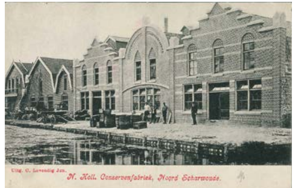
De Zuurkoolfabriek van Verburg heeft een in Neorenaissance stijl vormgegeven architectuur, 1905. De Zuurkoolfabriek werd in 1878 gebouwd door de Duitse firma Grellinger en Jansen, maar in 1894 overgenomen door P. Verburg en door hem omgedoopt in Noord-Hollandsche Conservenfabriek (herkomst: Noord-Hollandsarchief)
