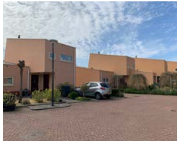
Woningbouw aan Albast, ontwerper onbekend, jaren negentig: In het centrum van Edelstenenwijk Oost aan Albast staat een complex dat bestaat uit geschakelde, kubistisch vormgegeven eengezinswoningen en dat door de licht hellende daken en het oranjepleisterwerk een Mediterraan karakter heeft gekregen.
