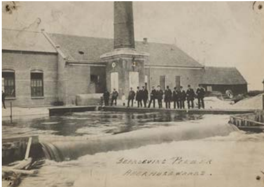
Het in 1877 gebouwde stoomgemaal, hier op een foto uit 1935, kwam te staan op de plek van drie poldermolens op het zuidoende van de Oostertoelt (Herkomst: RAA). Het gebouw werd tot twee maal toe vergroot. De twee stoommachines en twee centrifugaalpompjes deden hetzelfde werk als de 47 molens uit 1629. In 1994 werd het gemaal buiten bedrijf gezet. Vanaf toen heeft het de functie van Poldermuseum.
