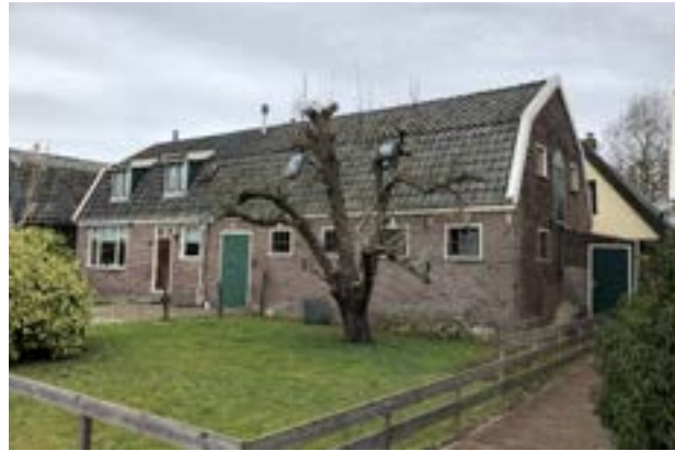
Op het Schapenland in Broek op Langedijk staat nog een tuinderswoning uit 1901 met koolschuur onder één dak. (herkomst: Langedijker Verleden)
