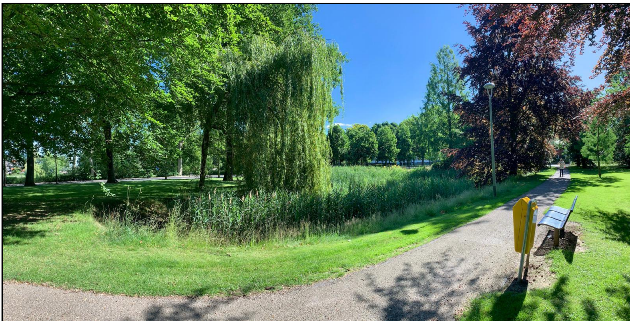
Figuur 3. Een wadi in de gemeente Brunssum welke via een bodempassage naar Parkvijver afvoert.
