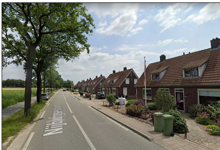
Figuur 3.3: Inrichting van de provinciale weg N837 verderop in westelijke richting
