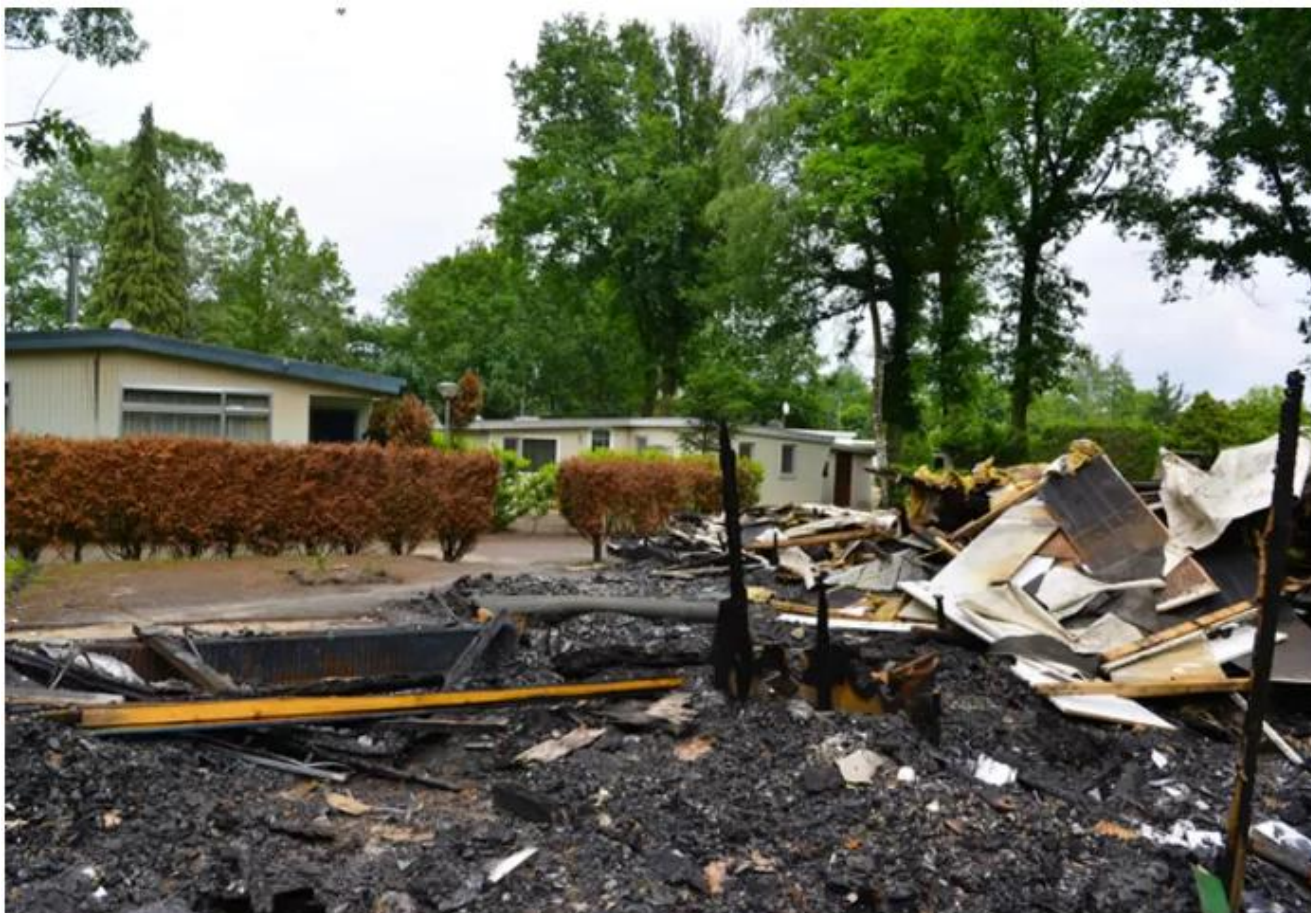
▲ Op meerdere plekken op het park zijn nog restanten te vinden van eerder afgebrande chalets. © Nienke vd Kruijs
