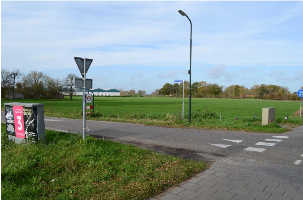
Figuur 2: Locatie zuidelijke aantakking van de nieuwe randweg aan de N605. Vanaf hier (kruising Gemertseweg – Mutshoek) loopt de randweg in noordwestelijke richting (in de zichtlijn op de foto).Foto: Kragten
