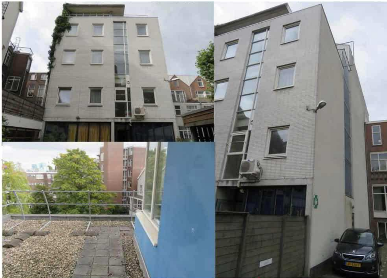
Foto-impressie plangebied: achtergevel, zijgevel en vijfde verdieping.
