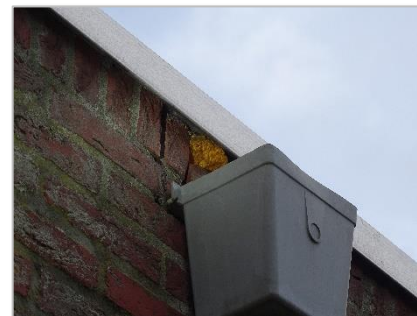
Foto 25: Openingen bij dakrand/aansluiting regenpijp.
