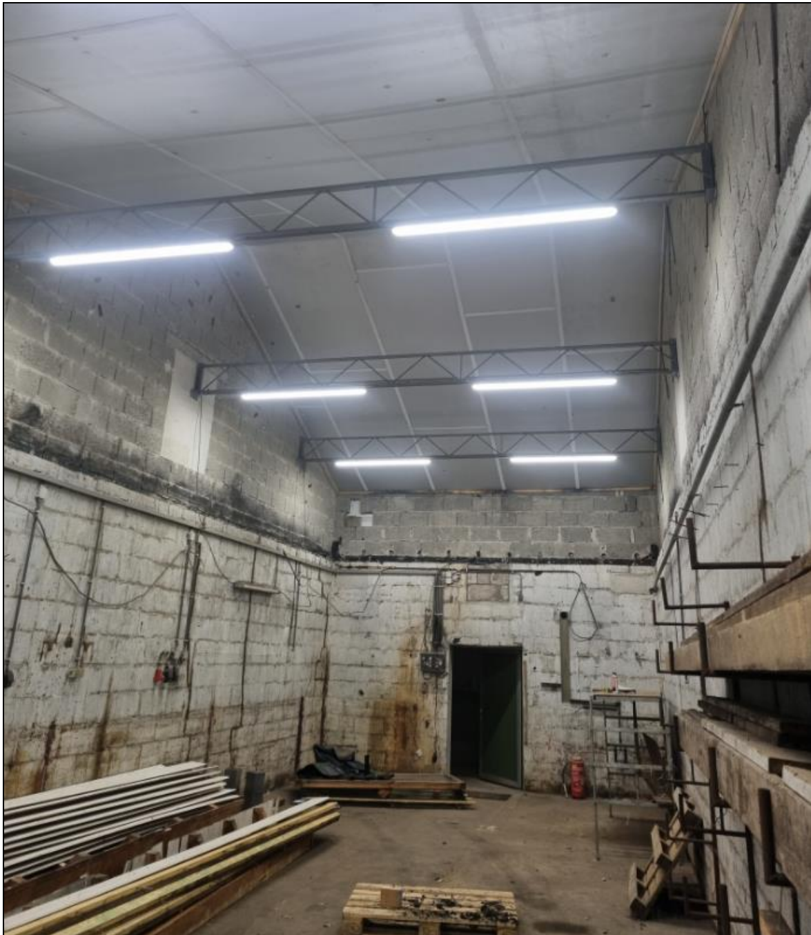
Figuur 14: Binnenzijde loods
