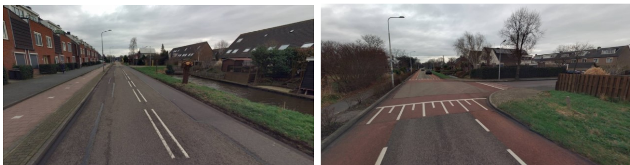
Figuur 15 – Links: Bilderdammerweg (zuid) met fietspad en voorrang geregeld. Rechts: noordelijk deel met fietsstroken en gelijkwaardige kruispunten (foto is kruispunt met Geerland)
