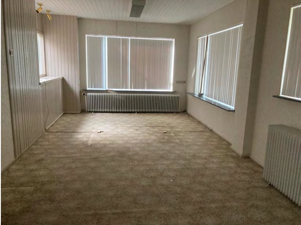
• Afbeelding 30: binnenzijde te slopen gebouw
