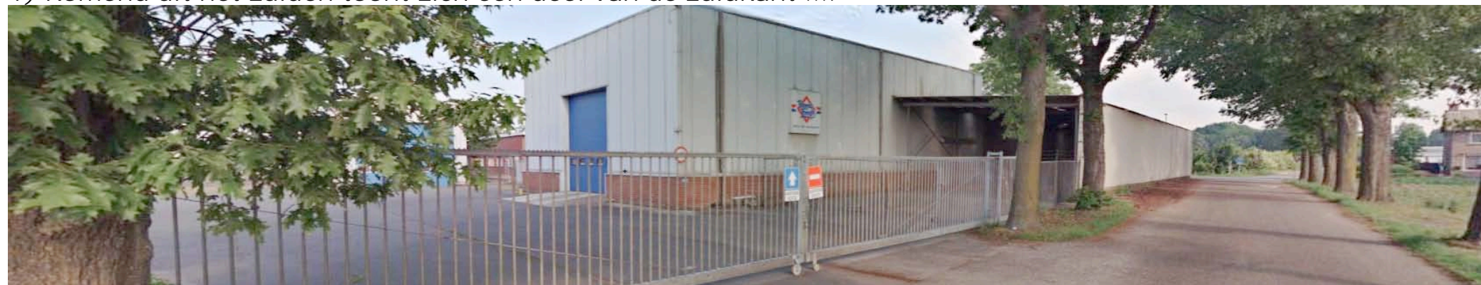
2) ...nabij het plangebied toont zich de oostkant; de bebouwing is te dicht op de weg gesitueerd
