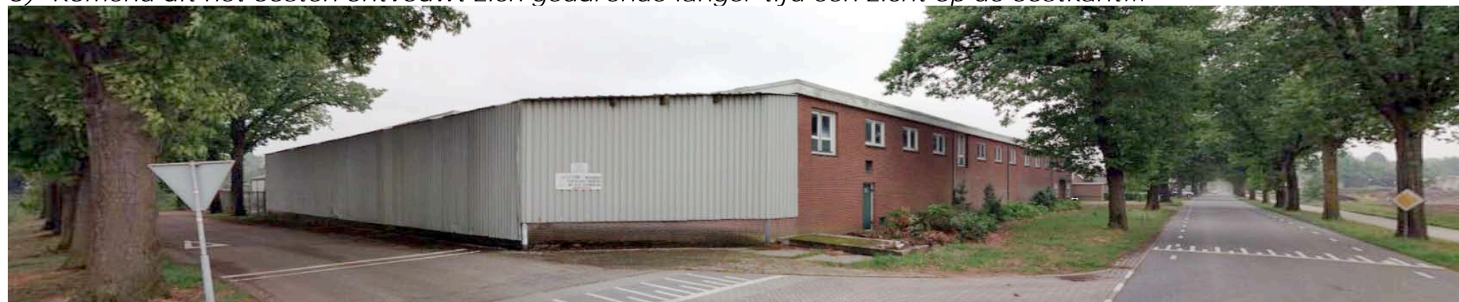
4) ter hoogte van de kruising met de Hoekstraat toont zich de bebouwing onevenredig zwaar
