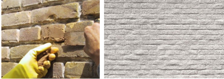
Figuur 5 – voorbeeld esthetisch metselwerkherstel en een afwerking met kaleien
