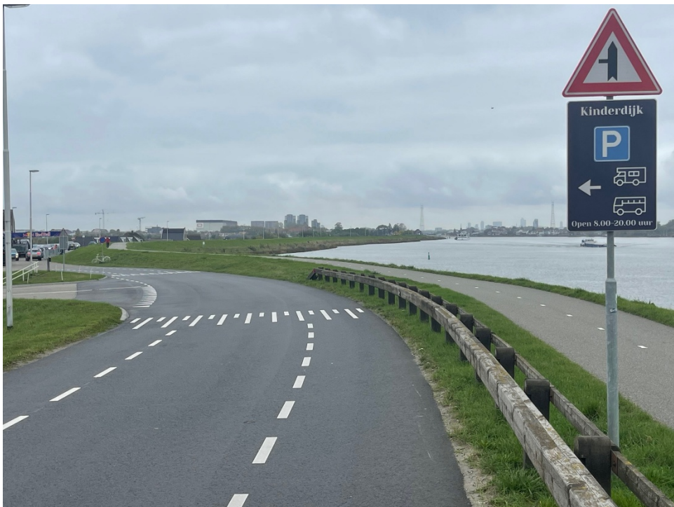
Het 2e verwijzingsbord vlak voor de afrit vanuit oostelijke richting; te klein en de openingstijden pas leesbaar als je bijna stil staat maar dan moet je al besloten hebben om linksaf te gaan zodat richtingaanwijzers de medeweggebruikers informeren dat een voertuig (bijna) stil staat.
